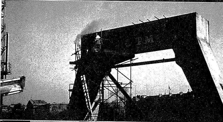
Fig. 19 à 23. — Phases de démolition d'un ouvrage provisoire en béton armé.
